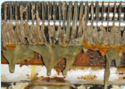
Moho dentro del refrigerador de exhibición
